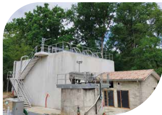
La station d'épuration de Montussan.
