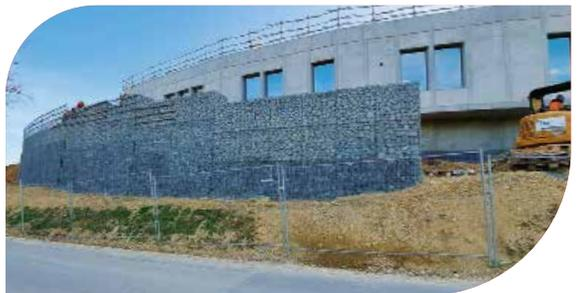
*Fin des travaux sur les réseaux extérieurs le long du bâtiment route d'Angeline et création du mur de soutènement en gabion.*
