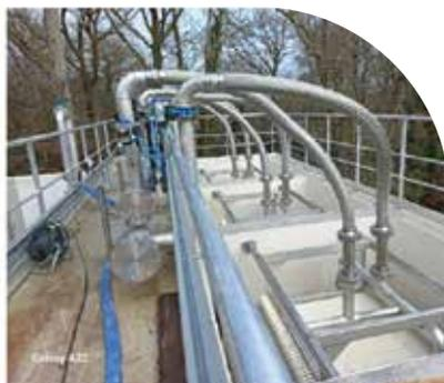
**Travaux sur la station d'épuration de Montussan.** Après plusieurs mois de travaux, le chantier de mise aux normes de la station d'épuration de Montussan est terminé. Cette dernière entre dans une phase de mise en régime pour observation. Ci-contre, le bassin d'aération et les cellules membranaires.
