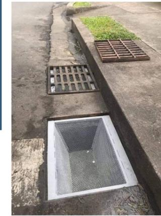
*L'installation de grille dans les receveurs permet de limiter la pollution des eaux*
